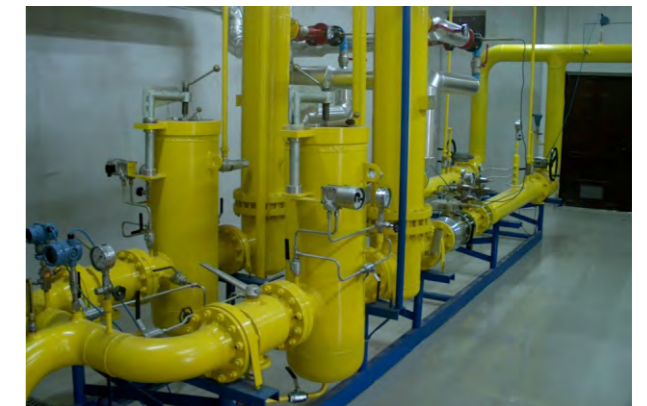
Mjesto ugradnje: Visoko za firmu BH GAS d.o.o. (BiH) GLAVNA REGULACIONO - MJERNA STANICA Q = 30.000 \text{ m}^3/\text{h} \mid p = 50 \text{ bar}
