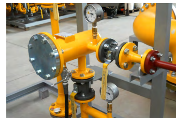
Gasni filter DN125 PN16 (Ugaona ugradnja)
